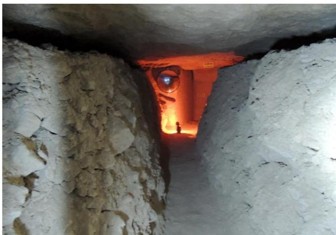
Depuis maintenant environ un siècle cette magnifique galerie du Puits à Daubin, large à cet endroit de 8,70 m, est remblayée ; cependant la tenue de son banc de ciel est impeccable. La tranchée ne recoupe que la moitié supérieure du remblai.
