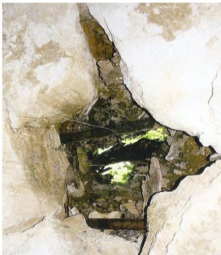
**Les 27 et 29 juin 2006** ce fut la réparation, la sécurisation du trou derrière la porte par un double coulage du béton : épaisseur totale 32 cm + 41 cm  $\approx$  73 cm.
