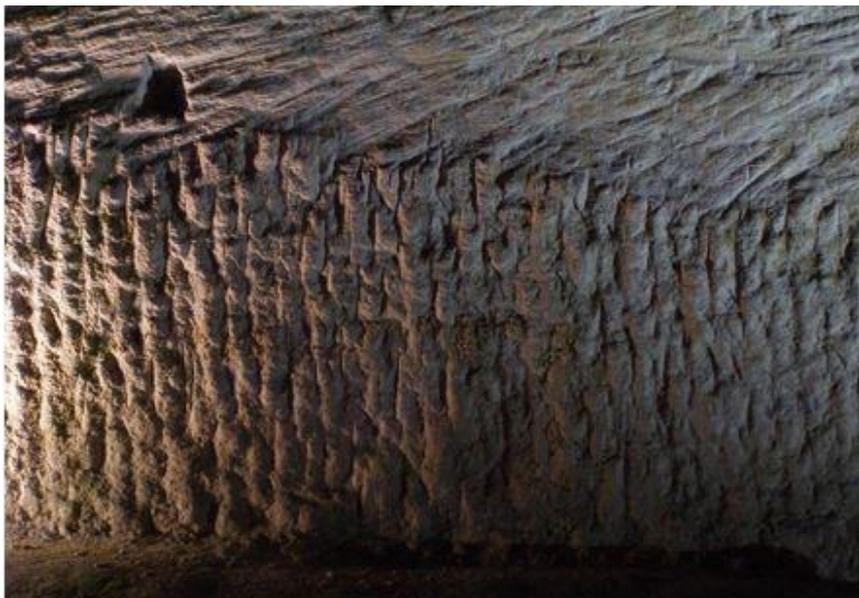
Ci-dessus, Traces d'une utilisation verticale de l'aiguille pour réaliser un surcreusement bas.
