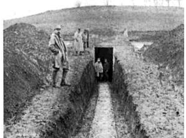
Entrée d'un hôpital souterrain
