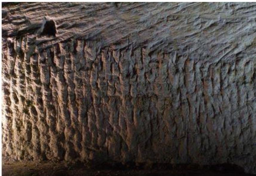
*Ci-contre, traces d'une utilisation verticale de l'aiguille pour réaliser un surcreusement bas*
