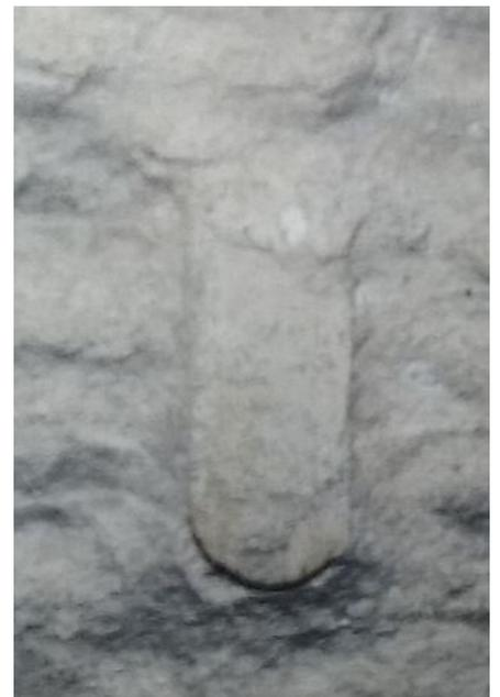
pratiquement à l'horizontale. Un bon coup de massette bien placé sur le haut du cylindre le coince définitivement. La suite est simple, l'aiguille est placée sur le cylindre servant d'appui et muni sûrement d'une gorge pour faciliter le coulisement, le creusement peut alors se poursuivre selon la profondeur totale de la saignée à creuser.
